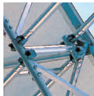
Las garras de anclaje rápido aseguran un montaje ágil al soporte tubular de la vigas para transmitir las cargas por las conexiones.
